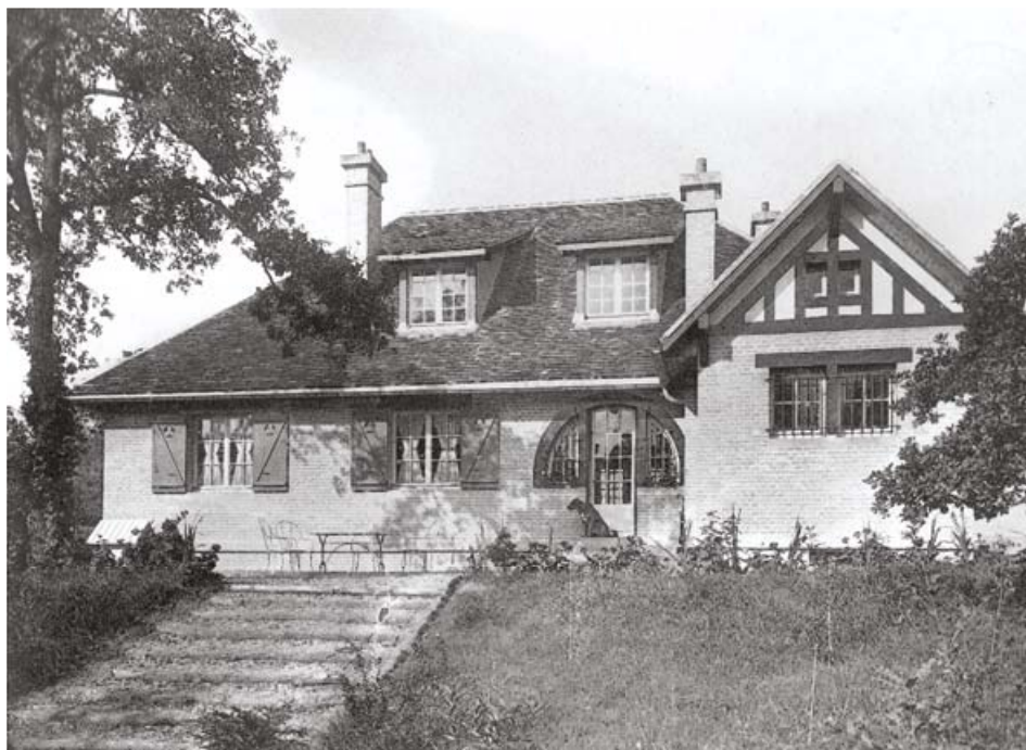
Villa Little Farm au Vésinet (S.-et-O.) - Façade principale. - R. Fournez, Architecte (D. P. L. G.). La maison que Robert Fournez se construit pour lui-même et sa famille, avant beaucoup d'autres.
